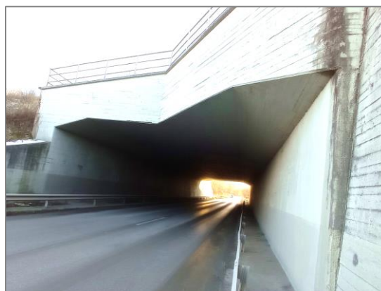
32. ábra: 1. sz. vasút - 81106 j. ök. út aluljárója
