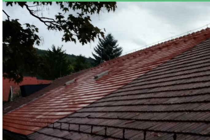
Dózsa György utcai óvoda részleges tetőcsere
