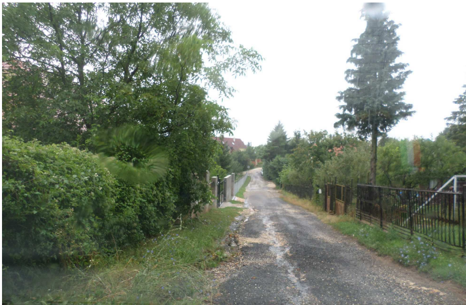
4.1.6.c/ A padka, folyóka kimosódása, pálya teherbírásának megszűnése
