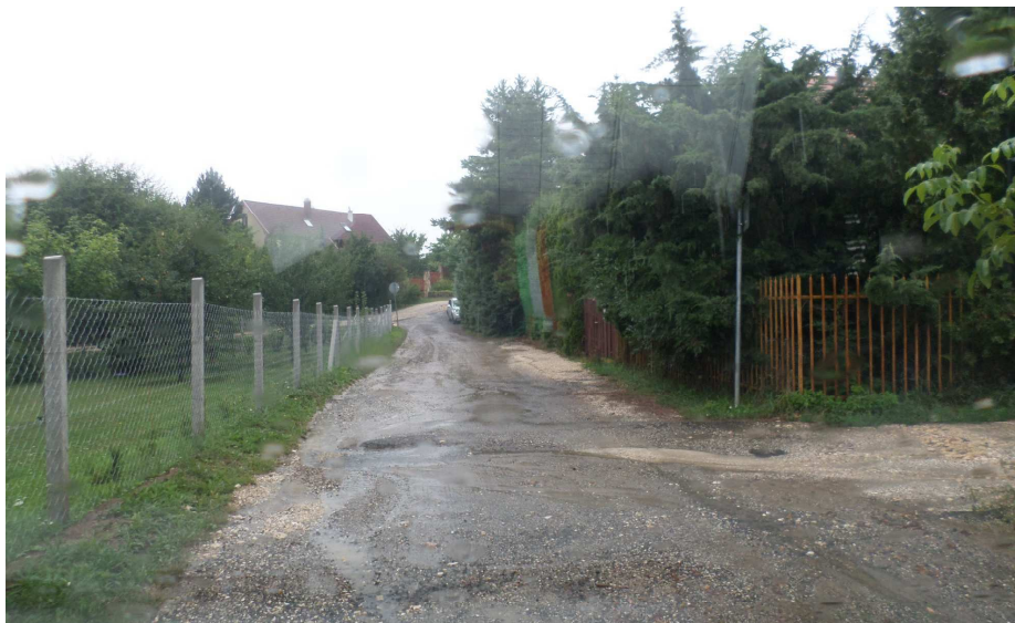
4.1.6.d/ A padka, folyóka kimosódása, pálya teherbírásának megszűnése
