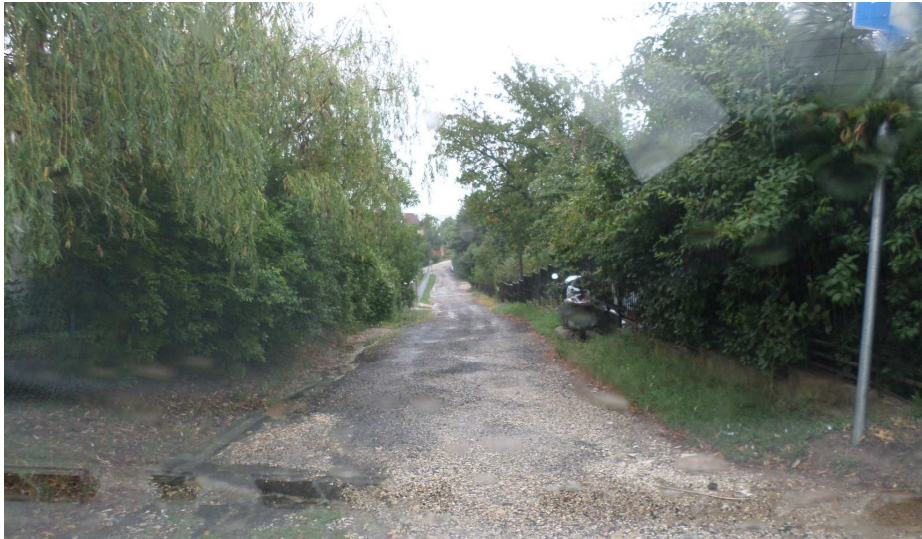
4.1.6.b/ Az út mozaikos tönkremenetele - teherbírását elvesztette -, hordalék lerakódással
