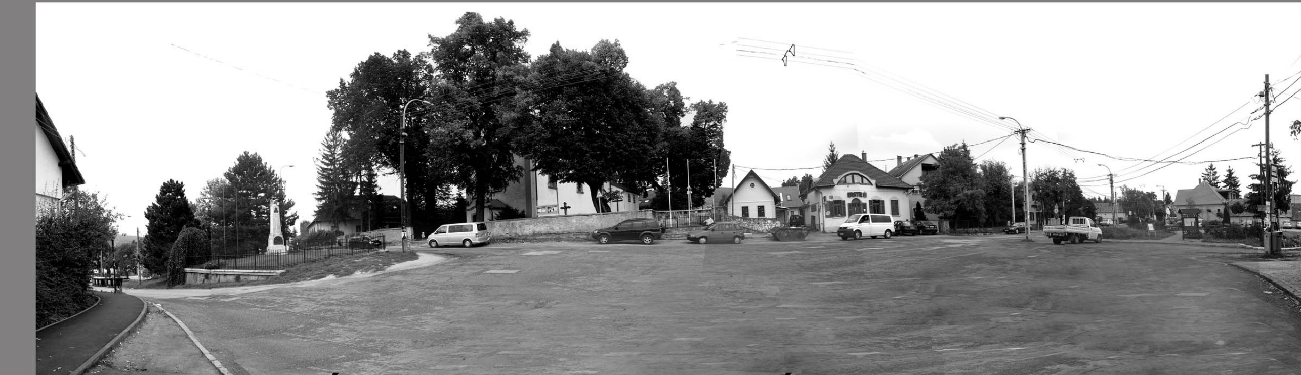
KÖZLEKEDÉSI RENDSZER HIÁNYA indokolatlanul nagy aszfaltfelülettel
