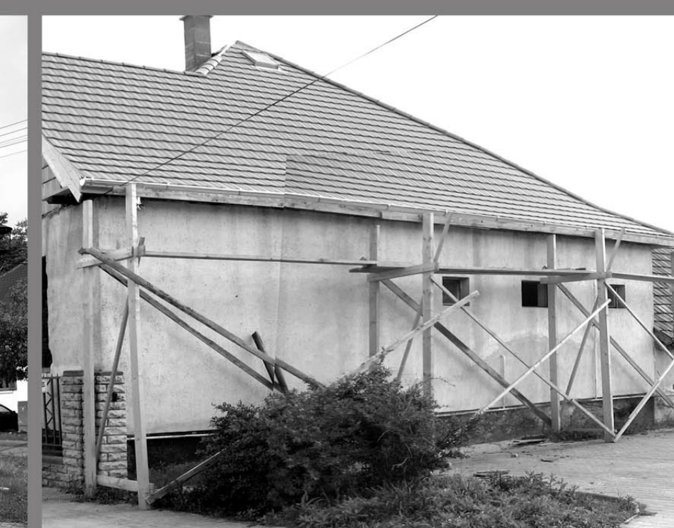
LAKÓHÁZ TŰZFALA zavarja az egységes tér érzetét
