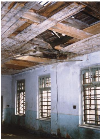
Györgyi Zoltán főépítész fotója, 1996
