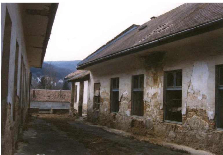
Györgyi Zoltán főépítész fotója, 1996
